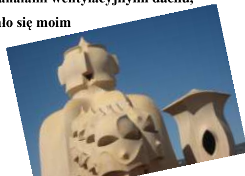
Casa Milá – fragment dachu
